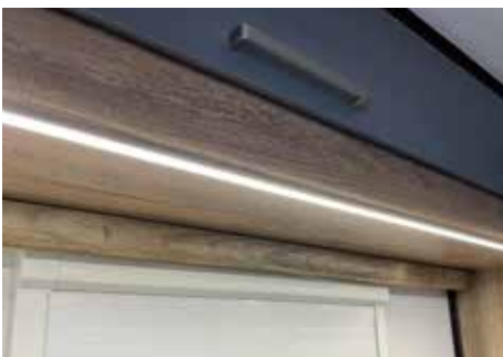
Interiérové LED osvětlení.
